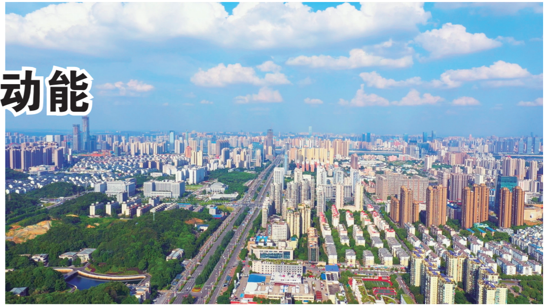
公主岭市主城区持续提升城市品质，打造宜居、韧性、智慧城市。
