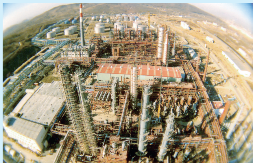
吉林石化30万吨/年乙烯装置建设现场。
