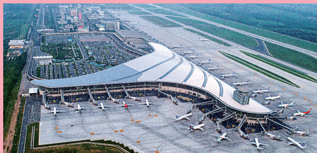
长春龙嘉国际机场2号航站楼。
