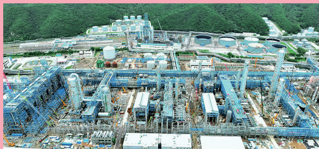
吉林石化炼油化工转型升级项目120万吨/年乙烯装置建设现场。
