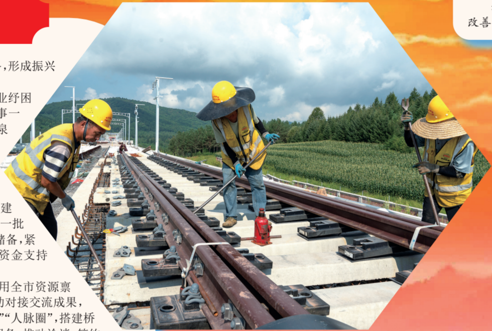
日前，由中铁二十三局集团承建的沈白高铁吉林段1-6标提速道岔铺设全部完成，为全线铺轨奠定了坚实基础。图为沈白高铁站场提速道岔铺设现场。杨景前 摄
