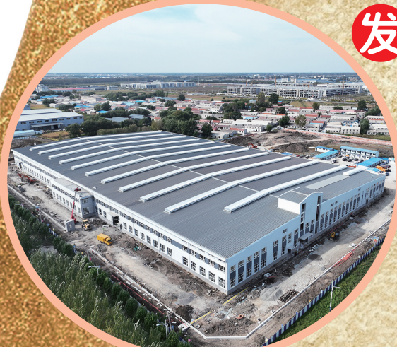
长春林泉汽车零部件有限公司二期智能化新建项目(一期)。
