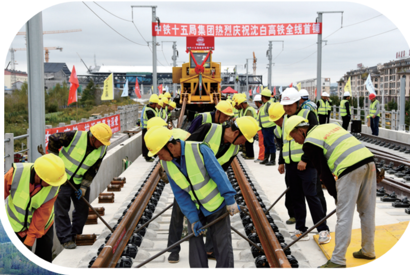
▲9月14日,中铁十五局沈白高铁吉林段建设工地上,建设者们有条不紊地安装着一节节铁轨,标志着沈白高铁这一国家重大交通基础设施建设项目正式进入铺轨阶段。王新 赵珍珍 摄
