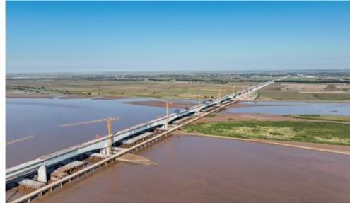
9月22日拍摄的包银高铁磴口黄河特大桥合龙现场(无人机照片)。当日，随着最后一节重达575吨的钢梁成功吊装，包头至银川高铁(以下简称包银高铁)的重难点控制性工程——磴口黄河特大桥实现全桥合龙贯通。包银高铁线路建成投入运营后，包头到银川列车旅行最快时间将由6小时缩短至2小时左右。
