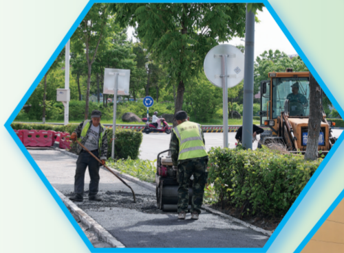
长白山管委会全力推进市容市貌环境综合整治，工作人员正在对人行道铺设沥青路面。
