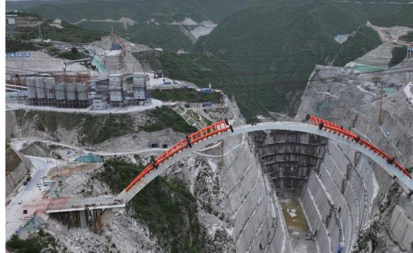
场(无人机照片)。当日,在中 铁二十局集团承建的陕西东庄 水利枢纽泾河大桥施工现场, 约120吨的全桥副拱最重节段 吊装成功,为后续建设奠定良 好基础。目前,各参建单位严 格把控施工节点计划,稳步推 进项目建设。东庄水利枢纽位 于陕西省咸阳市泾河峡谷,工 程建成后将成为陕西省库容最 大、坝高最高的水利工程。 新华社记者 张博文 摄
