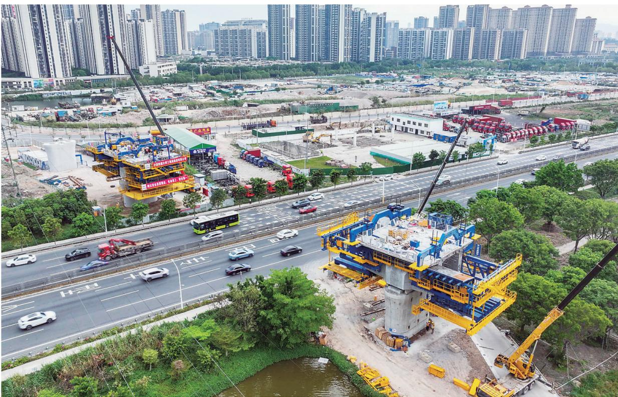
多功能悬臂智慧造桥机在深江铁路跨105国道沙漠特大桥上进行作业(3月31日摄,无人机照片)。
