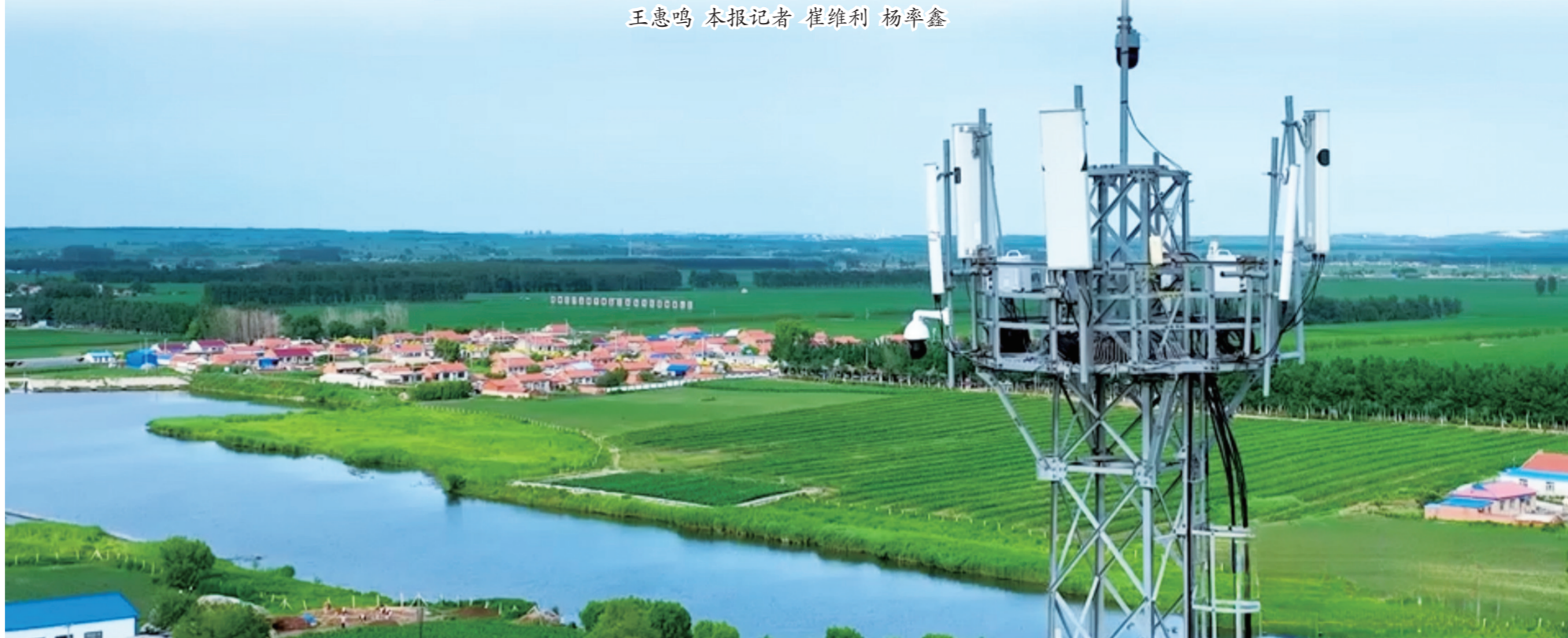
“数字四平”态势感知平台的前端，由智能摄像头和物联网传感器组成。图为在铁塔上安装的高空摄像头。
