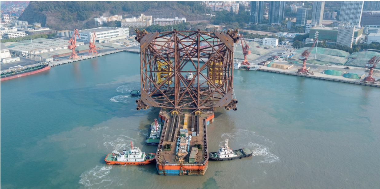
3月17日，在深圳赤湾海洋工程码头，“海洋石油228”运输驳船搭载着恩平20-4平台导管架启航(无人机照片)。当天，约1.2万吨重的恩平20-4平台导管架从深圳启航出海，奔赴深圳西南方约200公里的恩平油田海域。导管架平台是被广泛应用的海洋油气生产设施，主要由导管架和上部模块两部分组成，导管架相当于海上平台的基座，“扎根”海床，将上万吨的平台托举在海面上。恩平20-4平台是中国海油恩平15-1油田群的中心平台之一，就位海域水深约86米，导管架高104米。
