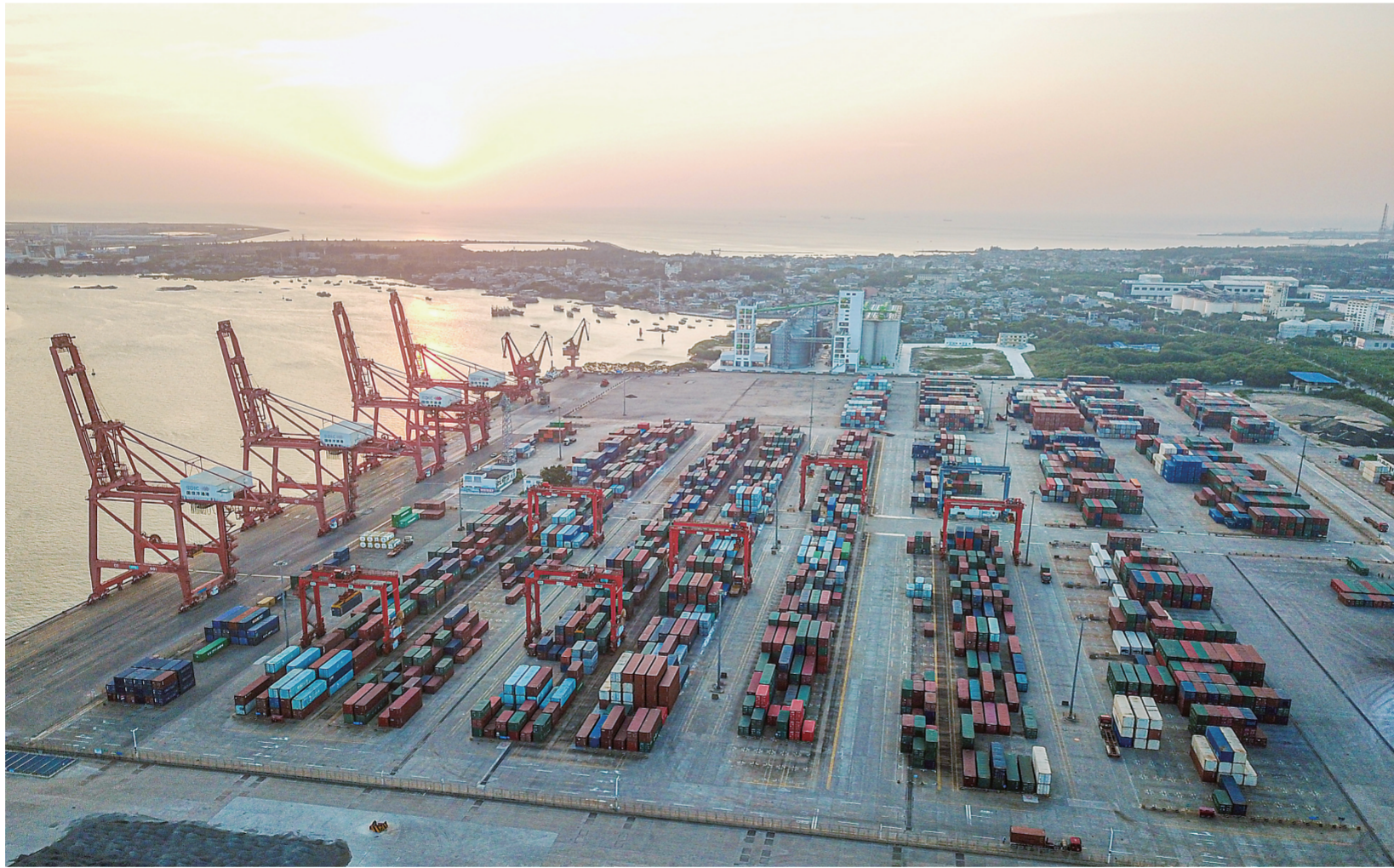
这是海南洋浦经济开发区国投洋浦港码头(无人机照片,9月25日摄)。
