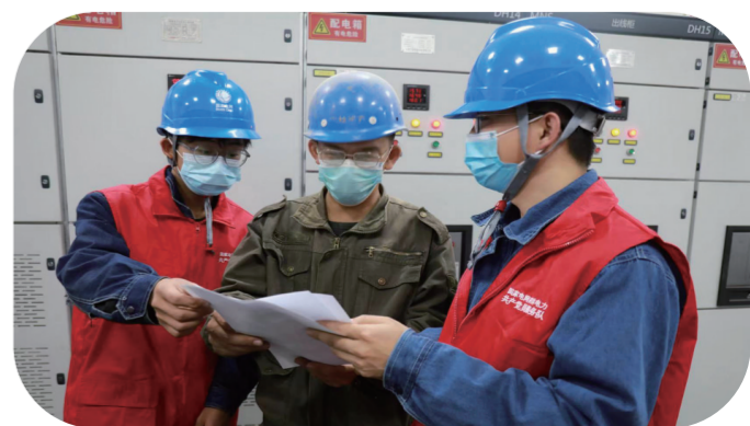
日前,国网松原供电公司前郭供电公司员工到辖区企业旭鑫油脂公司检查用电负荷情况,排查设备安全隐患。 吉翔洋 摄
