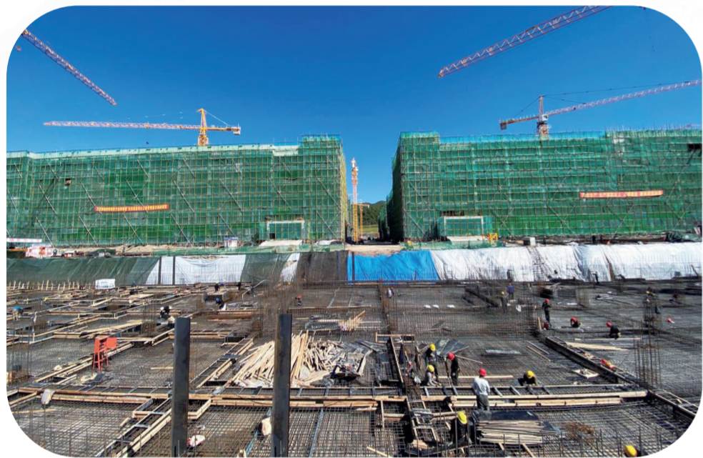
汪清绿电科技产业园项目建设正酣。杨佳琪 摄
