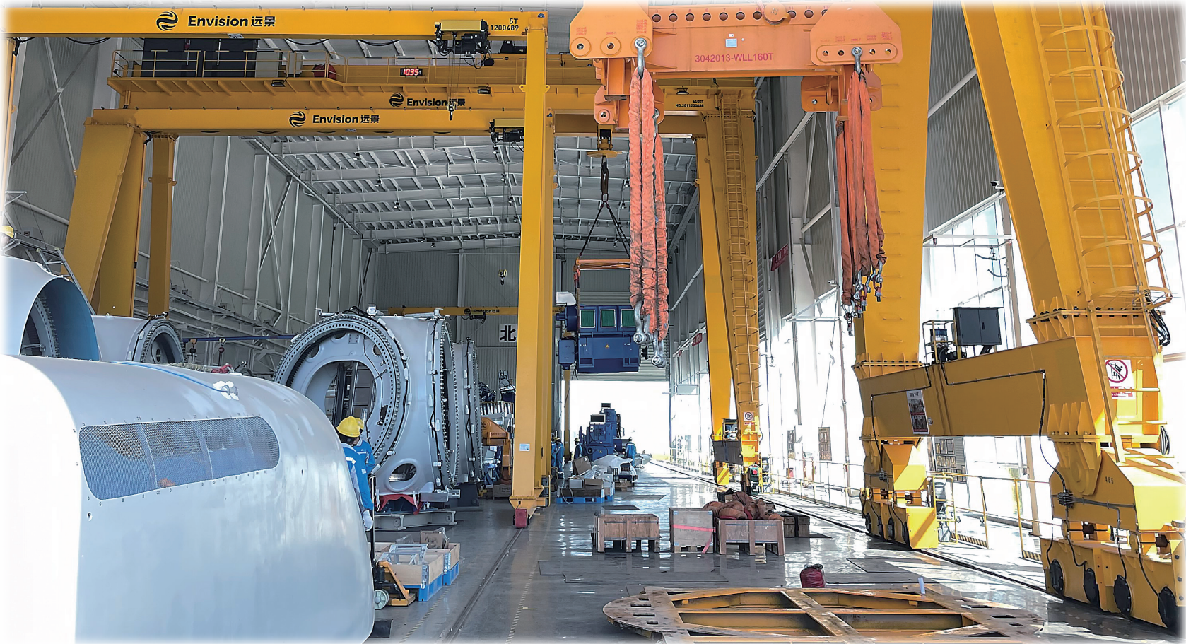
远景智能风机装备制造车间。
