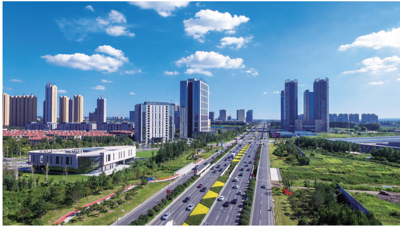
净月高新区谋划一批技术先进、成长性好、市场前景广阔的重大项目,不断更新充实项目库,为全区经济发展蓄积后劲。图为生态大街连片发展的项目集群。
